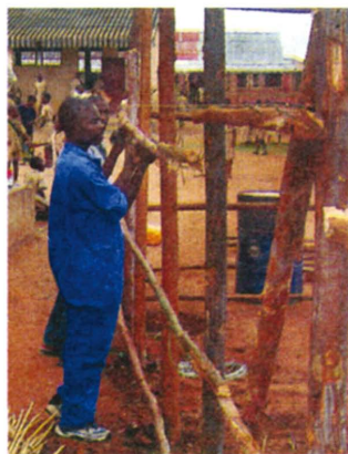
Bouwwerkers werken aan een nieuw leslokaal in Bujumbura. FOTO AFP
